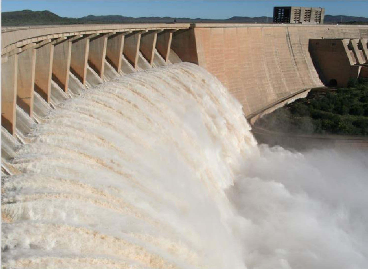
Barrage de Gariep Dam (Afrique du Sud)
